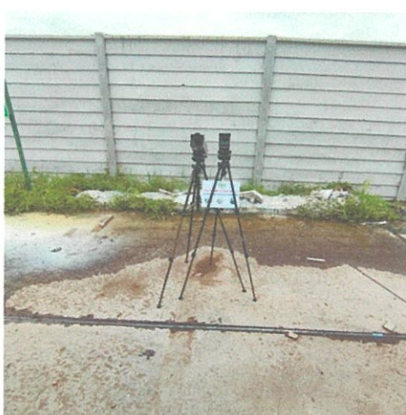
ภาพที่ 4 ริมกำแพงด้านข้างอาคาร Boiler
