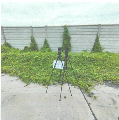
ภาพที่ 5 รีมก้าแพงระบบบำบัดน้ำเสีย เฟส 2
